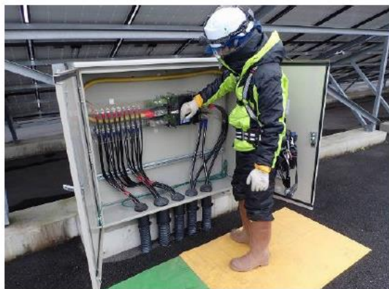
遮断器の停止操作は右手で行う(PCS停止済)
