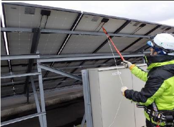
PV、延長ケーブルの検電
