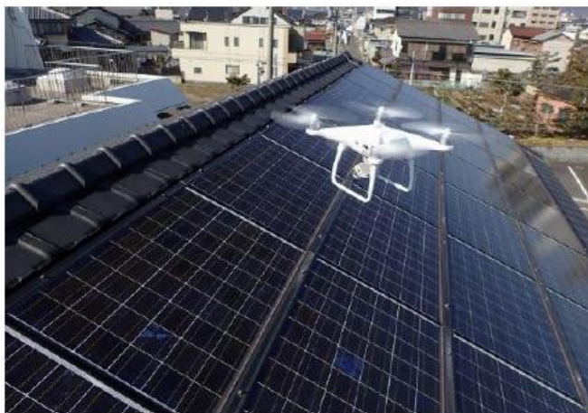
ドローンのカメラ映像による屋根上の点検
