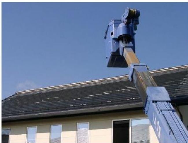
高所作業車で目視による点検
