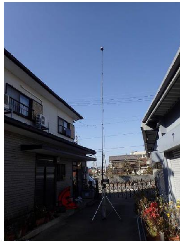
高所カメラの映像による屋根上の点検
