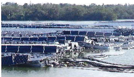
太陽光発電設備崩壊（暴風）
