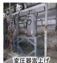
変圧器嵩上げ
