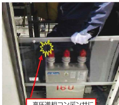
高圧進相コンデンサに 接触し感電（推定）
