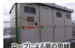
ロープによる扉の固縛
