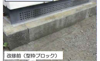
既設設備改修例
