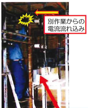
交換作業中に断路器に触れ感電
